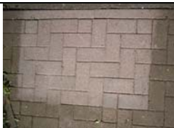
Après nettoyage avec une brosse en métal et rinçage à l'eau, après séchage
